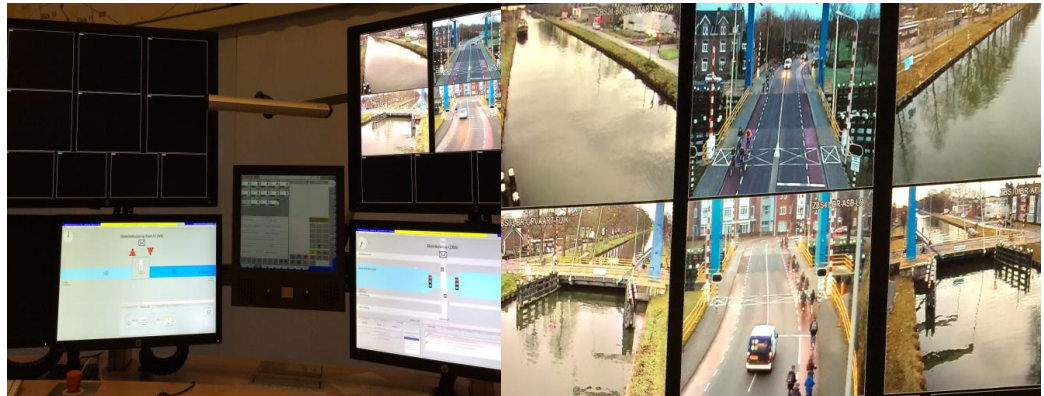
Figuur 2. Vier bedieningsschermen beschikbaar voor observatie in bedieningscentrale Tilburg. Inclusief een ingezoomde weergave van videobeelden van de Biesterbrug.
