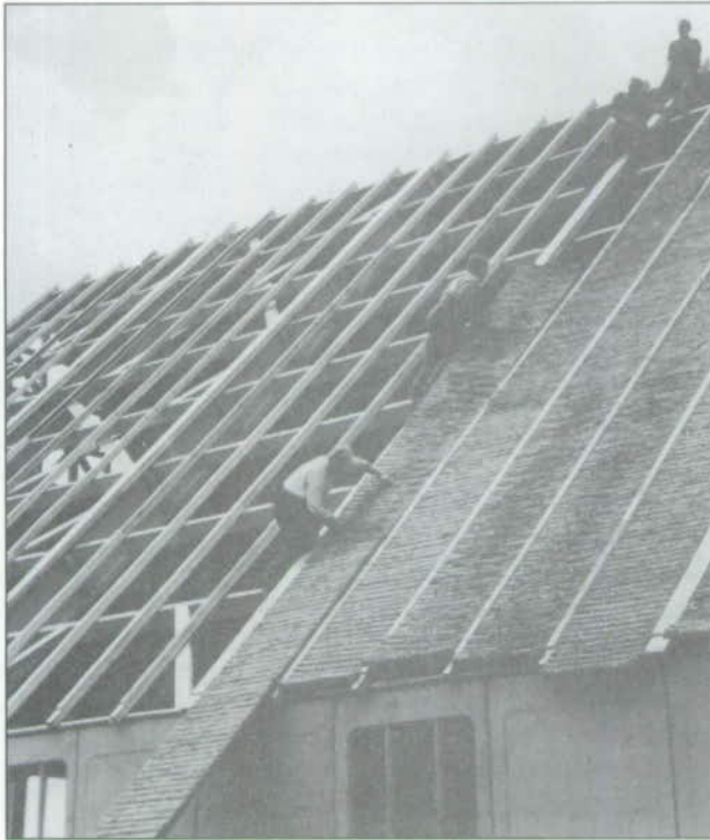
Foto 41: Aanbrengen van rietmatten tussen de sporen.
